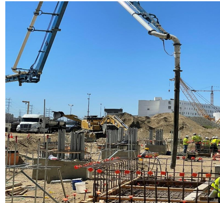
TPSS Pad Framework and Concrete Pour
