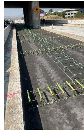
Preparation for SB JPCP Pour
