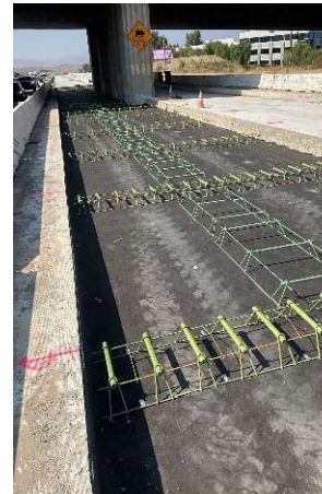
Preparation for SB JPCP Pour
