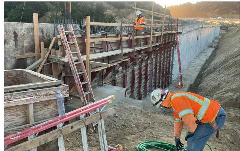
Retaining Wall 2460 Ready for Pour
