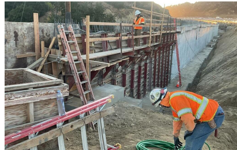
Retaining Wall 2460 Ready for Pour
