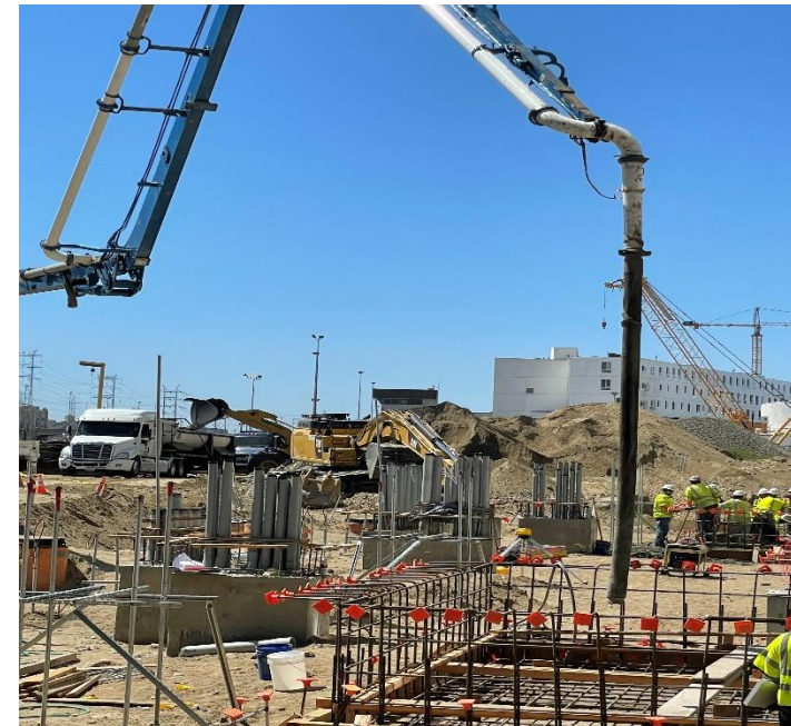
TPSS Pad Framework and Concrete Pour
