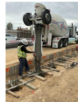
SW 2676 Pile Concrete Pour
