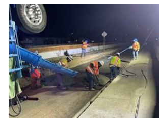
105WB first pour of base material on pavement
