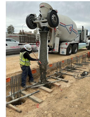
SW 2676 Pile Concrete Pour
