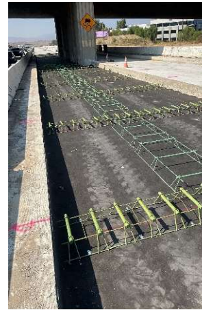
Preparation for SB JPCP Pour
